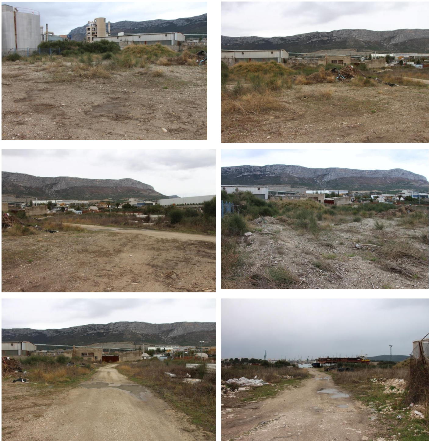
Slika 7. Lokacija zahvata – postojeće stanje
